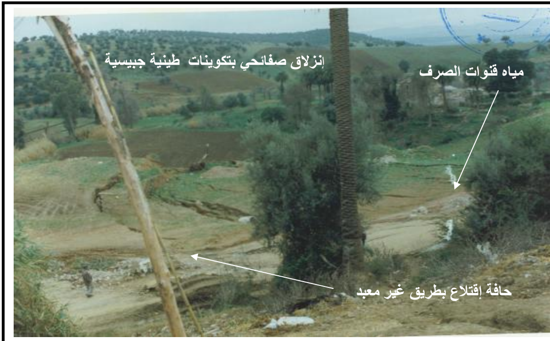
صورة رقم : 10 إنزلاق الطريق الوطني رقم 21 (1999)
